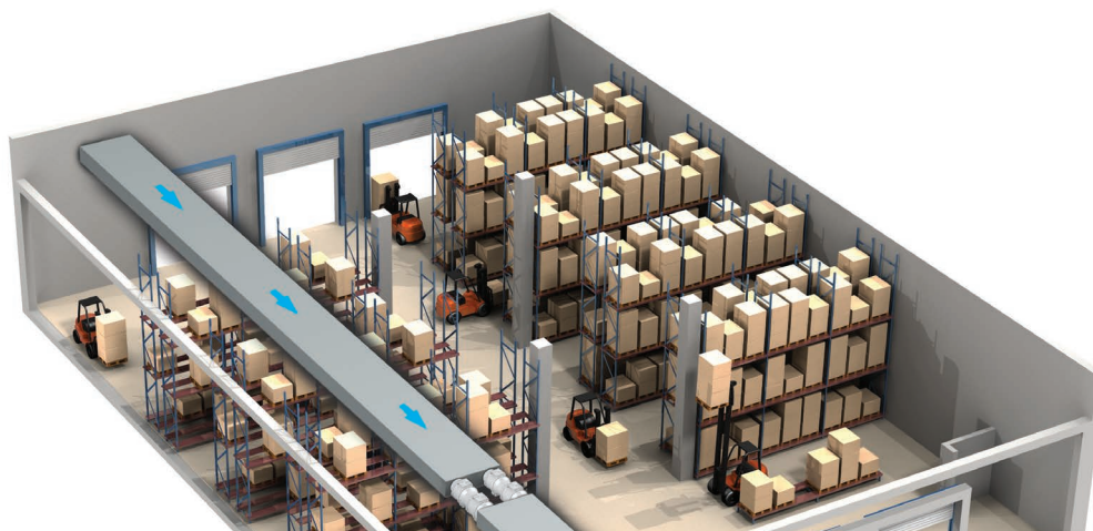
Паралельне встановлення вентиляторів на складі для підвищення продуктивності
